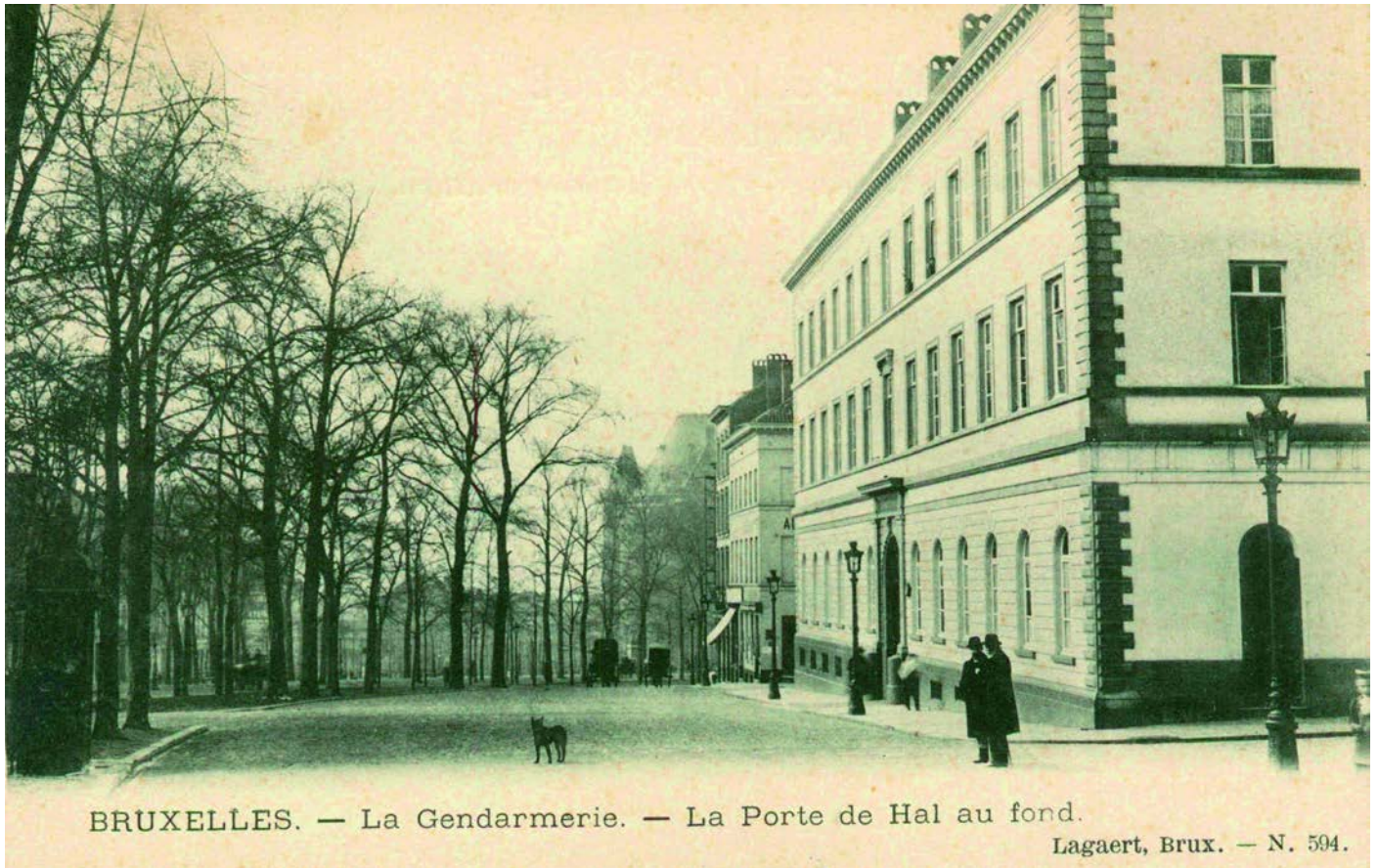
De Rijkswachtkazerne aan de Waterloolaan, Louis Spaak, 1840. Ze werd in 1874 vergroot door provinciaal architect Hansotte en gesloopt in 1921.
